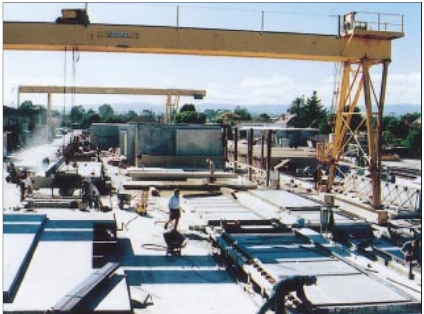
SA PRECAST PLANT IN ADELAIDE
